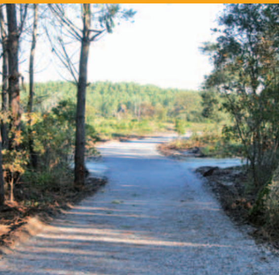
Tronçon de la future piste nord-sud
