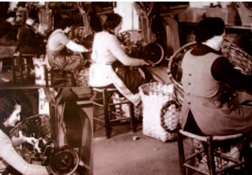
Ancien atelier de l'usine Pontneau
